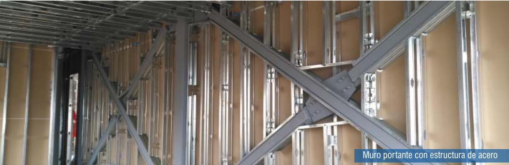
Muro portante con estructura de acero
